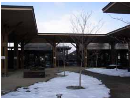
写真8 有備館駅の市民協働館「ユービック」
